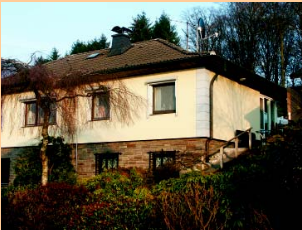
Wärmedämmverbundsystem mit Deco Profilen und Bossensteinen
