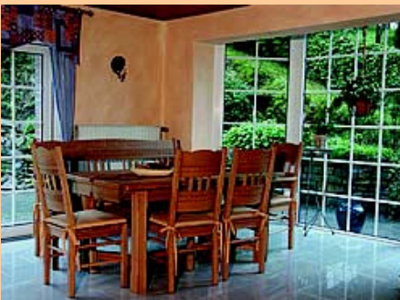
Wandgestaltung mit Modellierputz in grob, mit einer Lasurbeschichtung Bodenfläche und Sockel mit Italgraniti
